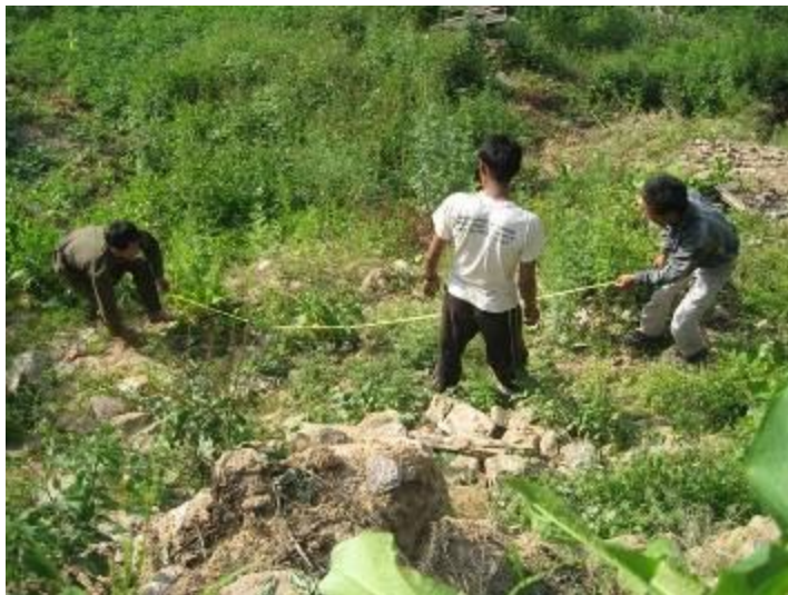
Vermessung der Schutz- und Stabilisierungsmauer
