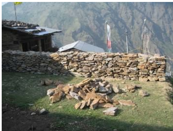
Steine für den Bau der Schutzmauer
