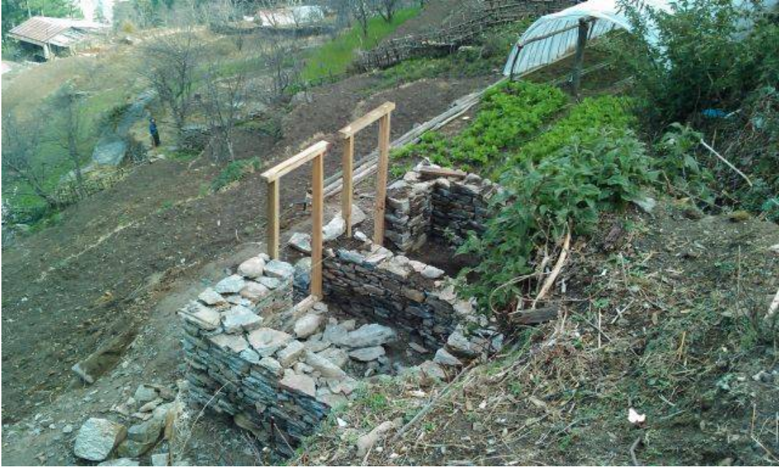
Bauarbeiten Gemeinschafts-Dusche Brabal
